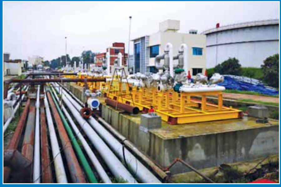
চিত্র: অটোমেশনের লক্ষ্যে স্থাপিত কাস্টিডি ট্রান্সফার ফ্লো-মিটার
